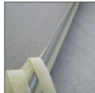
5. Mit einem scharfen Stecheisen die Oberfläche abziehen.
