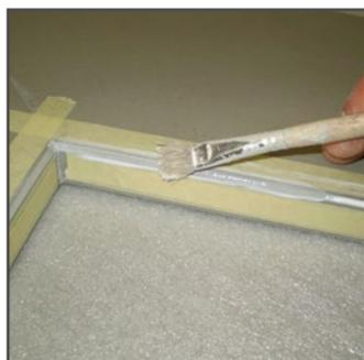
3. Nach dem Antrocknen/Anziehen nochmals die **Plus**-Versiegelung mit dem Pinsel auftragen. Je nach gewünschter Schichtdicke wiederholbar!
