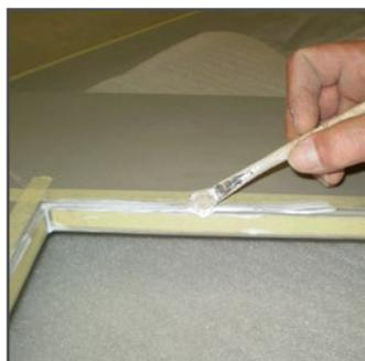
4. Nach ca. 30 Min. das Kreppband abziehen. Dann über Nacht trocknen lassen.
