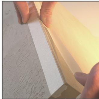
4. Die Beschichtungsmasse dünn aufbringen und trocknen lassen.
