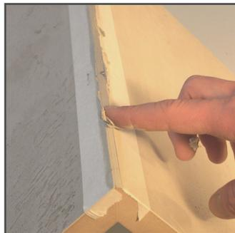
5. Kreppband abziehen und mit einem feinen Schleifschwamm (150er) beischleifen.
