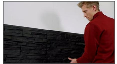
Nachdem Sie das erste Paneel befestigt haben, gehen Sie bei den folgenden Paneelen genauso vor. Dabei wird das zu befestigende Paneel immer stramm an die Stirnseite des bereits angebrachten Panels geschoben.
